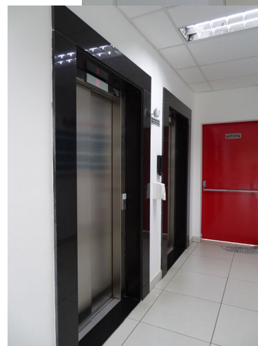
Elevadores foram equipados com sistema de abertura automática das portas em caso de falta de energia
